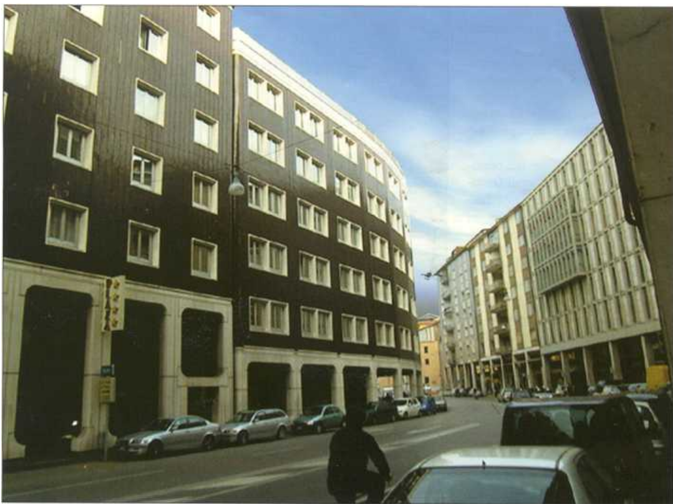
L'Hotel Plaza: un moderno complesso alberghiero nel cuore di Padova che ha scelto per il condizionamento dei suoi ambienti un impianto a metano Robur
