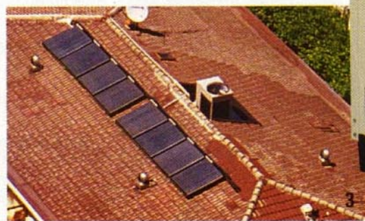
Fig. 2 - La produzione dell'acqua refrigerata è affidata ad un assorbitore a gas metano raffreddato ad aria per installazione esterna, posizionato in copertura all'edificio, su un piccolo terrazzo di servizio (Robur, serie GA, modello ACF 60-00).
