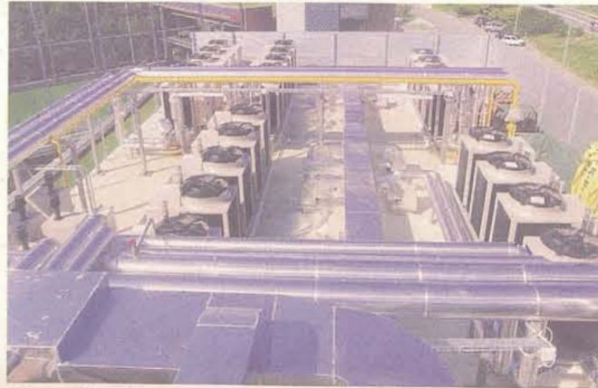
Calore pulito. Un sistema di climatizzazione basato su pompe di calore ad assorbimento realizzato dalla società bergamasca Robur
