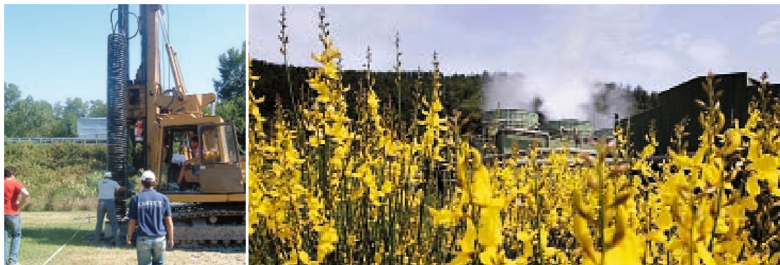
Una centrale di Enel Green Power a Larderello. A sinistra, l'installazione di una sonda a spirale di Energy Resources
