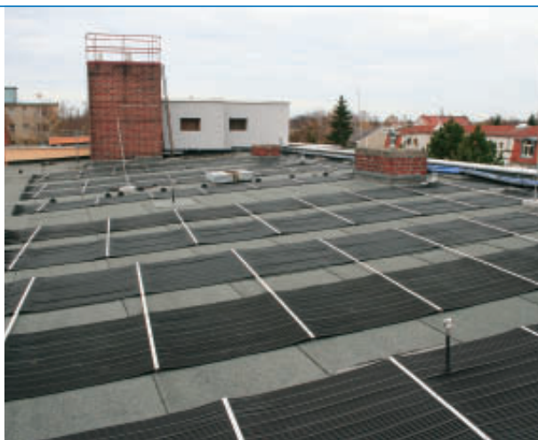
Abb. 3a + b: Das aus konventionellen Schwimmbadabsorbern aufgebaute Absorberfeld kann auch schon bei geringen Einstrahlungswerten seinen Betrieb aufnehmen und das Erdreich regenerieren.
